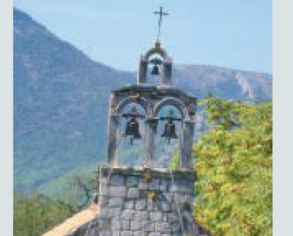
Schiet: Den Glockenturm versetzte ein Erdbeben in seine Schräglage.
